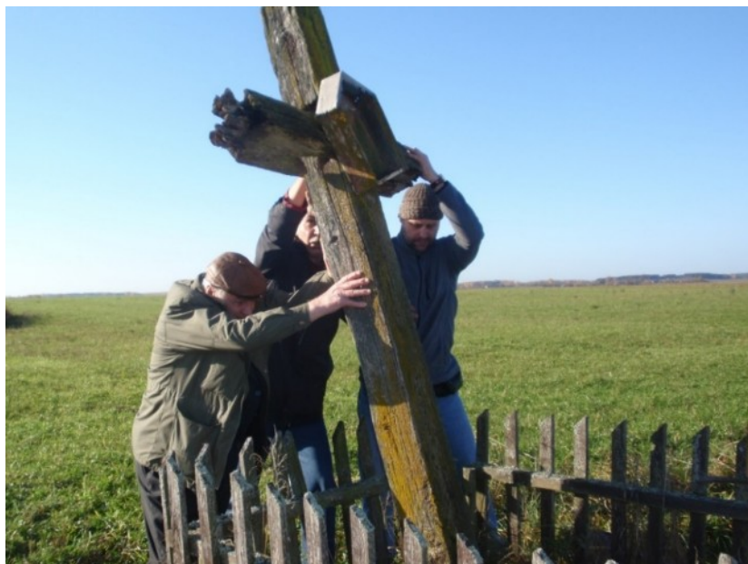
Zygmunt Olszewski, Robert Gasiński i Bartłomiej Garba przy naprawie powstańczego krzyża, 2013 rok
